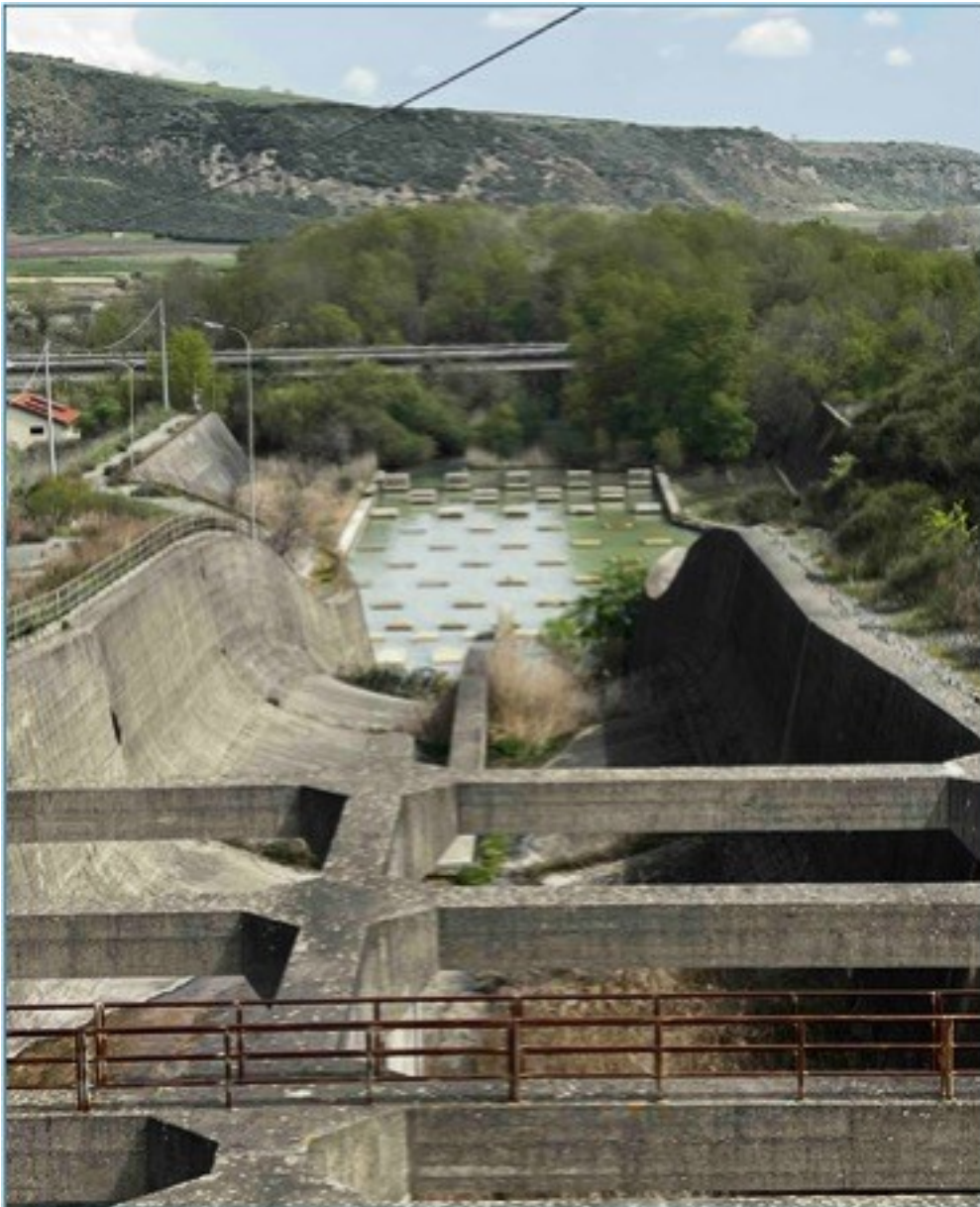
Foto 3. Scarico di superficie. Sono visibili lungo il canalone i dissipatori dell'energia.
