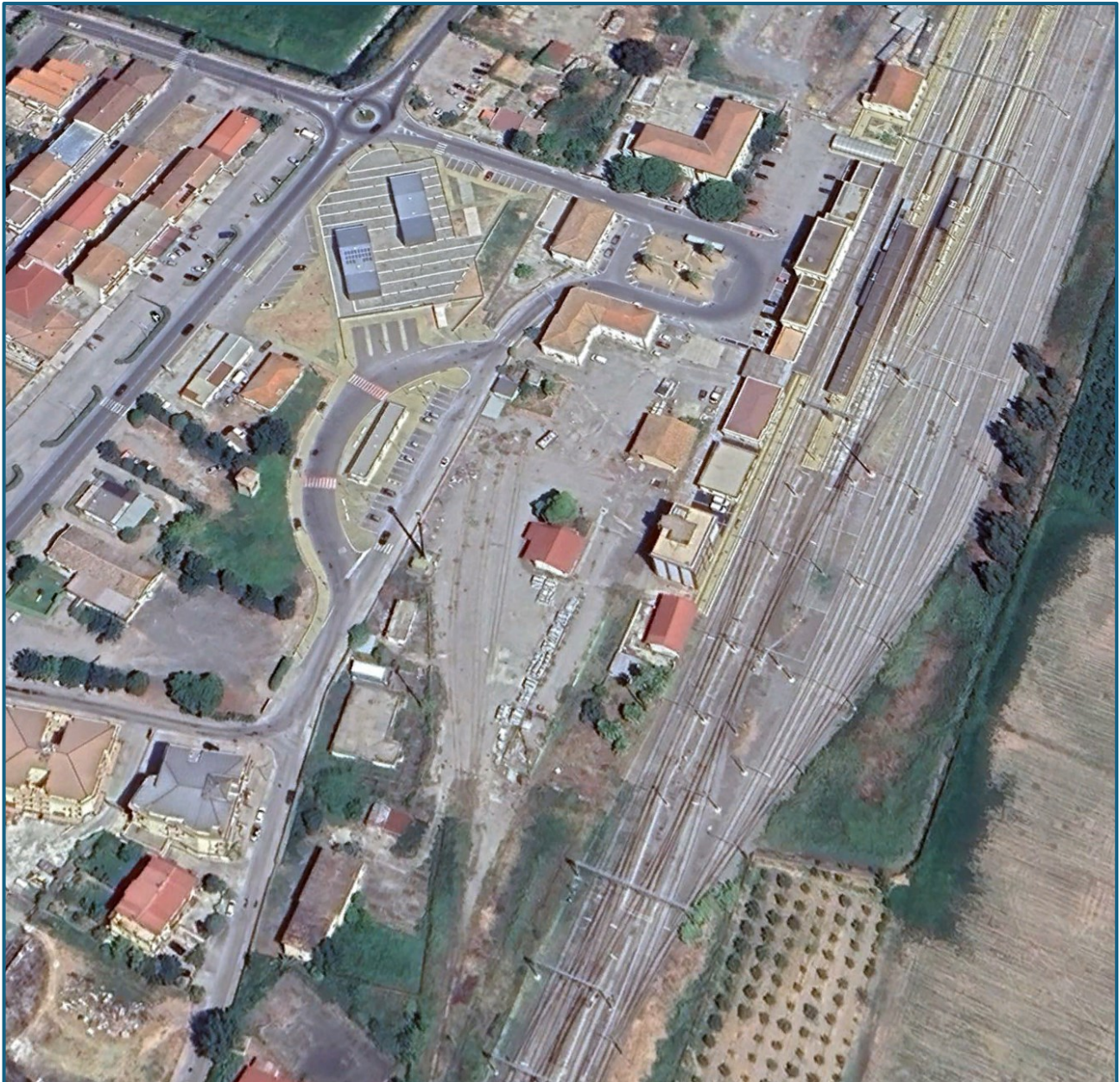
Fig. 9. Area Ammassamento soccorritori – Parcheggio antistante stazione ferroviaria di Sibari.
