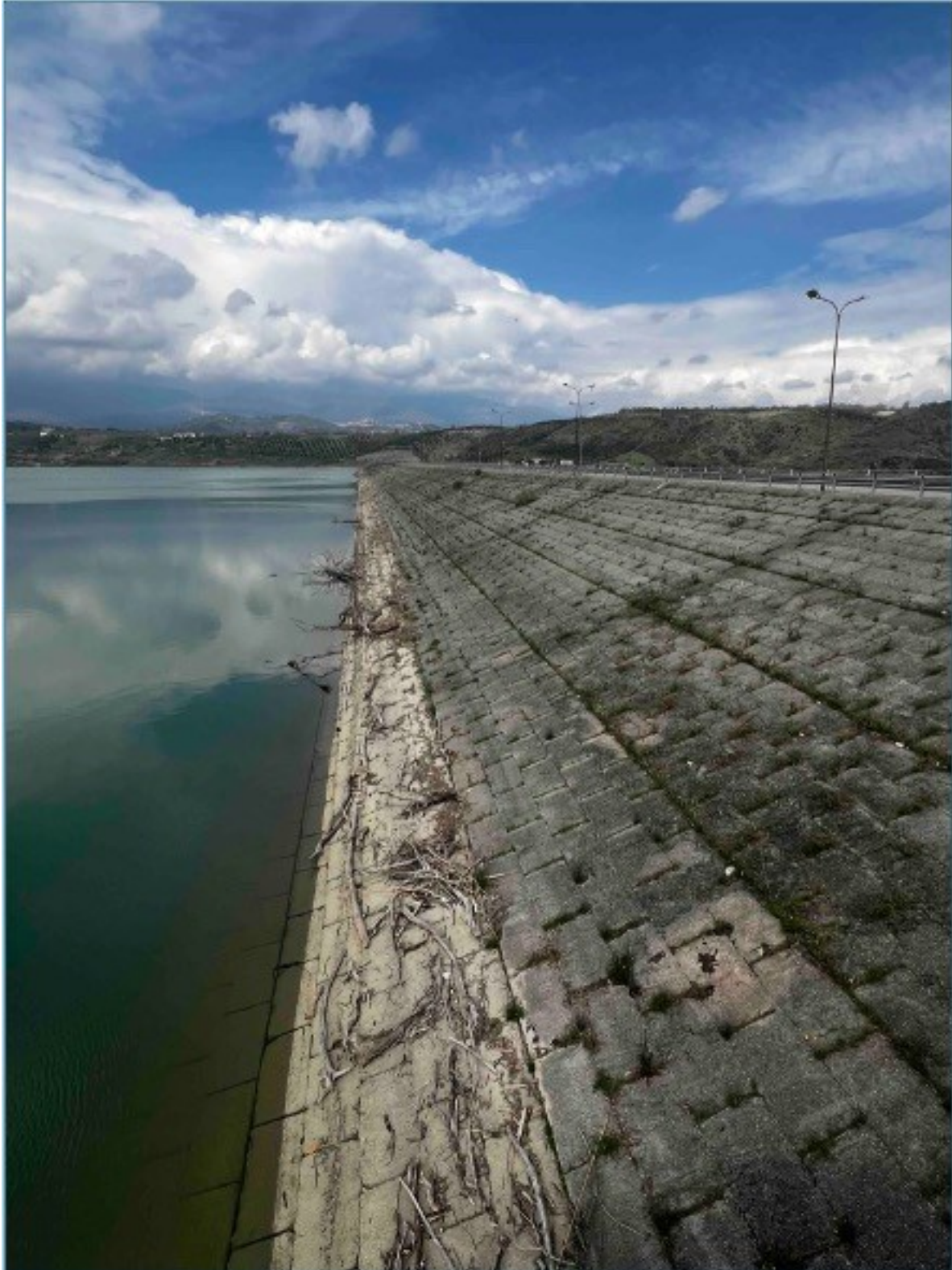
Foto 2. Particolare del paramento di valle.
