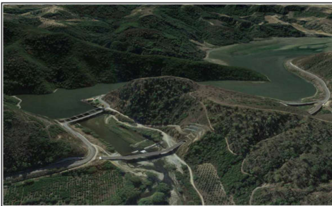
DIGA TARSIA – FIUME CRATI
