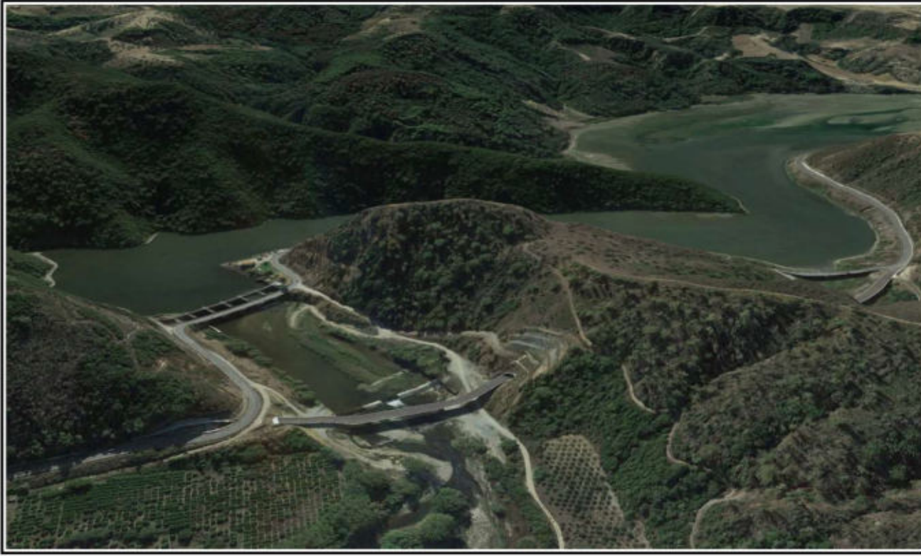
DIGA TARSIA – FIUME CRATI
