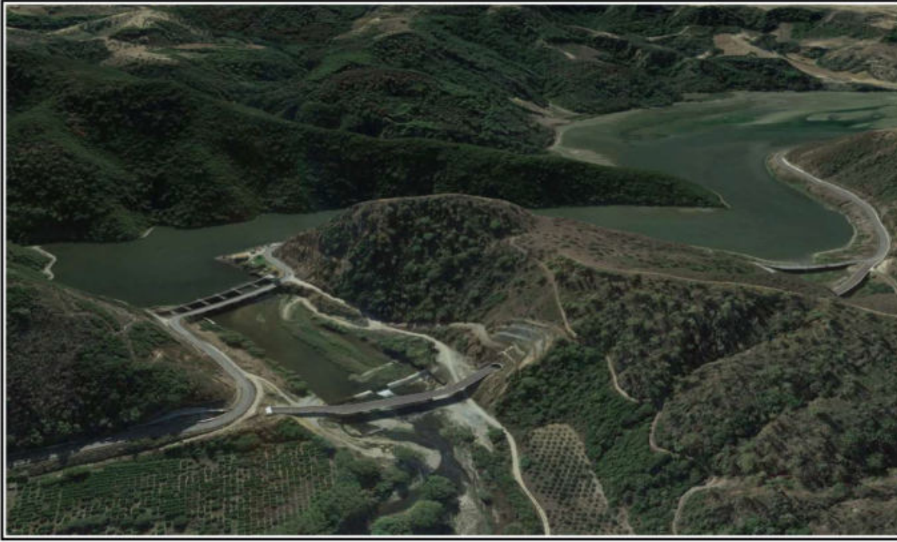
DIGA TARSIA – FIUME CRATI
